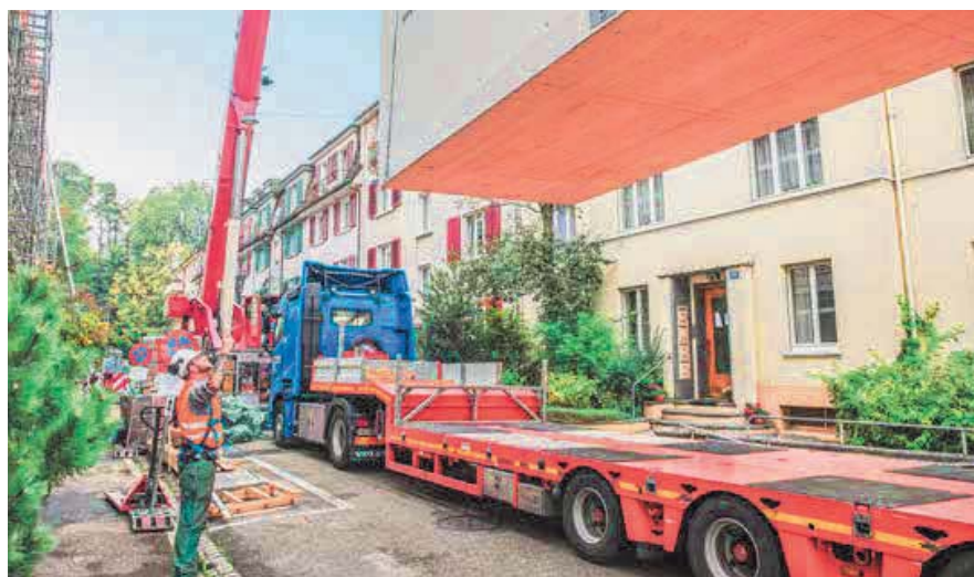
An einem einzigen Tag wurden die vier Zimmermodule aufgebaut.
