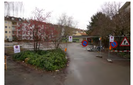
Baustelle Riehenring im Februar 2018
