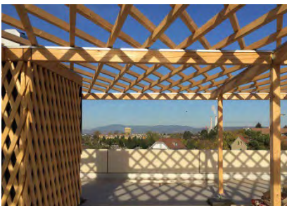
Dachterrasse für alle
