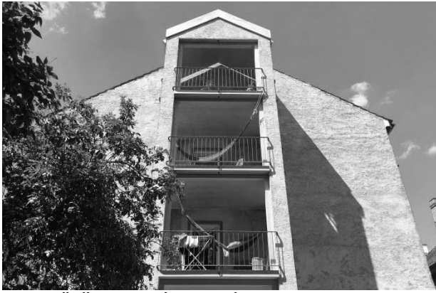
Neue Südbalkone Hinterhaus Mörsbergerstrasse
