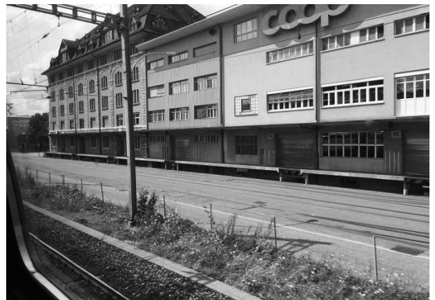
Areal Coop Verteilzentrale Pratteln mit über 40'000 m2
