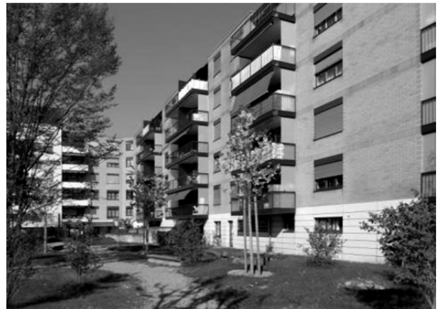
Erneuerte Balkone an der Sempacherstrasse
