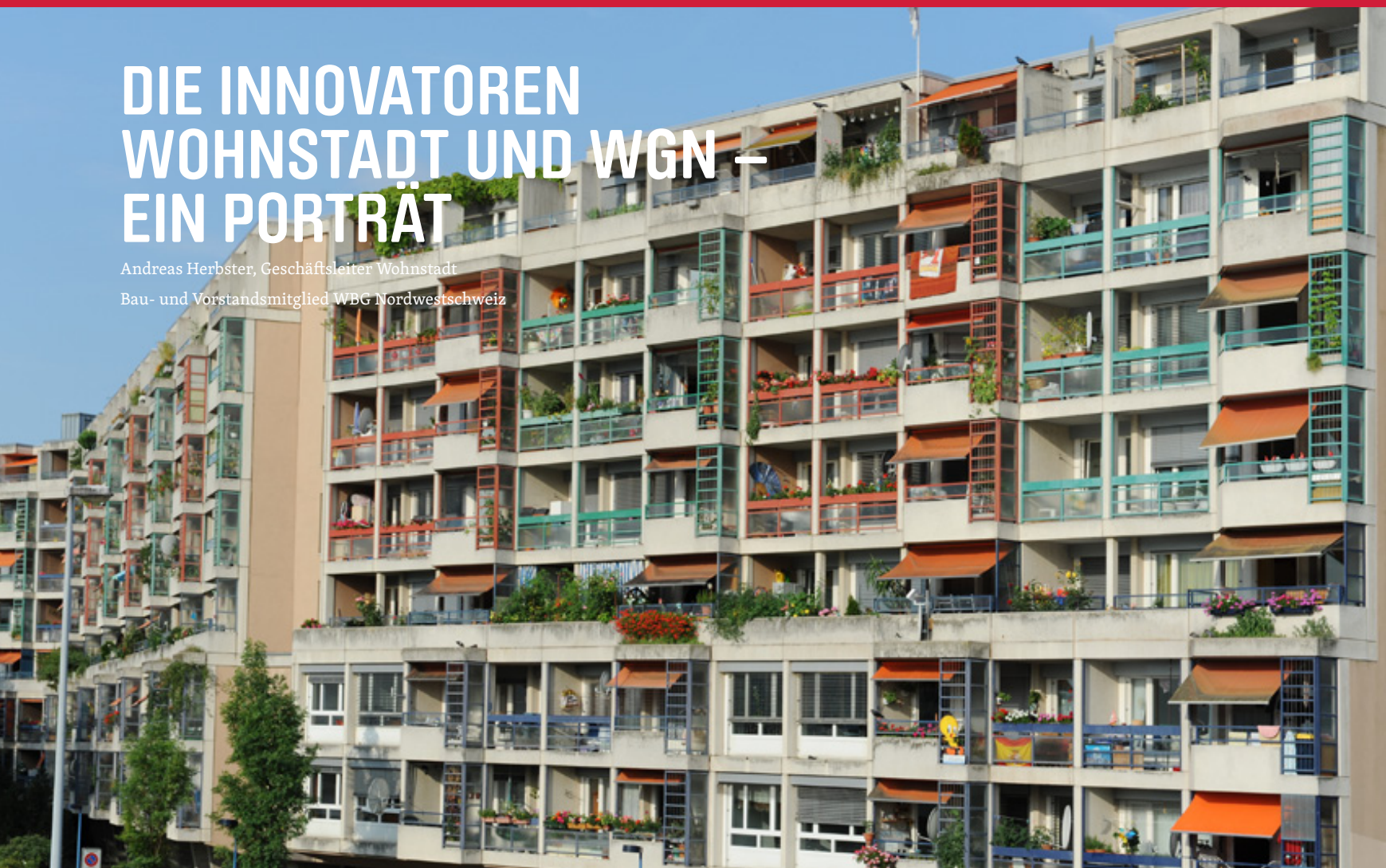
Abb 47: Die Überbauung St. Johanns-Parkweg direkt am Rhein. Hier konnte der WGN bezahlbaren Wohnraum schaffen, wie es ihn sonst mitten in der Stadt kaum mehr gibt.
