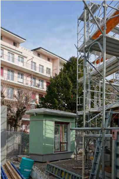
Baustelle Riehenring 3 mit Mock-Up Fassade
