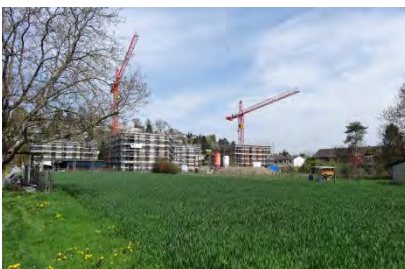
Reinach Bodmen: Im Hintergrund des Bauplatzes die Neubauwohnungen der Seniorenwohngossenschaft Rynach.
