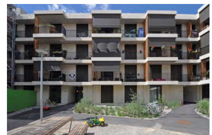
Balkone auf den Hof
