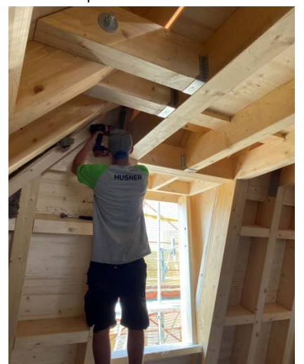
Massiver neuer Dachstuhl an der Wattstrasse: Er bindet das Haus für den besseren Erdbebenschutz zusammen
