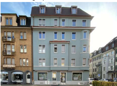
Aufstockung und Sanierung Wattstrasse
