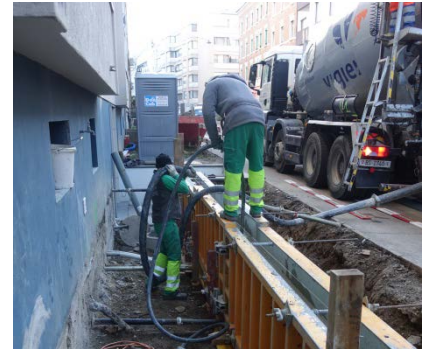
Rampe Oetlingerstrasse: Werkleitungen musste tiefer gelegt werden, da Überdeckung um ca. 20cm reduziert wurde.
