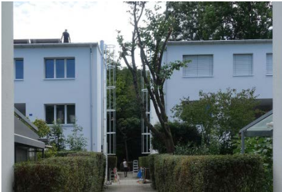
Erneuerung Dach-/ Fassaden Aesch
