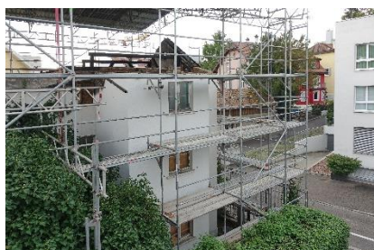
Kernmatt: Brandruine vor Baubeginn
