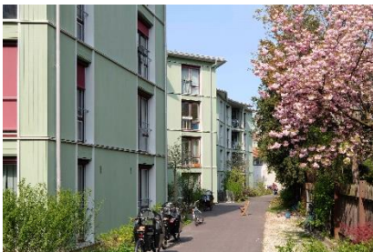
Zugang Riehenring 3/3a
