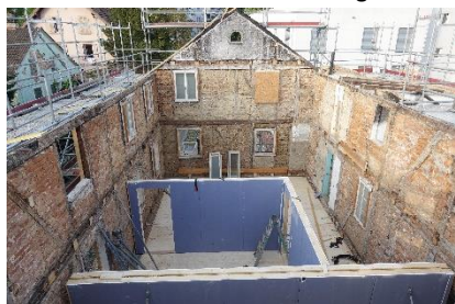
Das neue Innenleben entsteht in Holz
