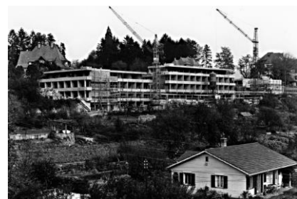
Bau Dominikushaus in den 60er Jahren.
