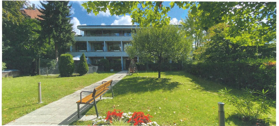
Upcycling – was vom Bau aus den 60er-Jahren übernommen werden kann, wird in das Projekt Domino von Wohnstadt integriert.
