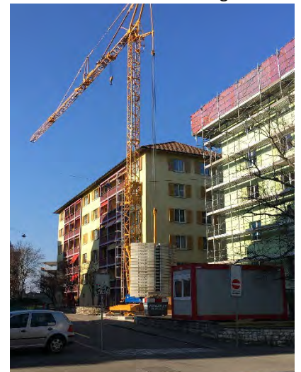
Für die Sanierung lohnt sich ein Kran
