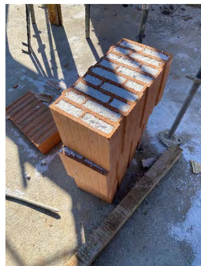
Minergie P Bauweise mit Einsteinmauerwerk
