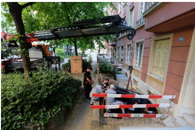
An der Laufenstrasse wird eine Luft-/Wasser-Wärmepumpe eingebaut.
