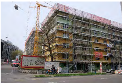
Wird seltener: Sanierungsbaustelle
