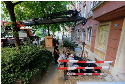
An der Laufenstrasse wird eine Luft-/Wasser-Wärmepumpe eingebaut.
