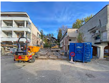
Rückbau des Zwischentrakts
