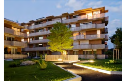
Seniorenhochhaus Lärchenpark in Münchenstein
