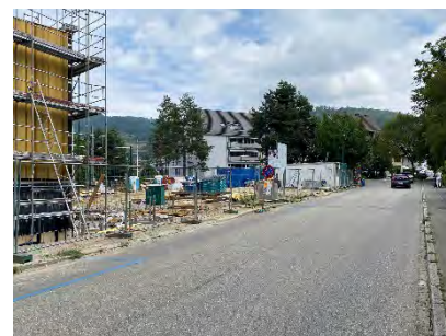
Der Bauplatz neben dem neuen Gemeindesaal im Zentrum von Arlesheim
