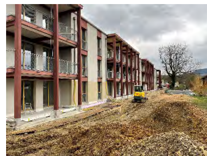
Frühling 2024: endlich ohne Gerüst
