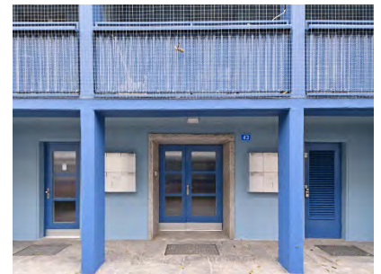
Neue Eingangstüren / Balkongeländer
