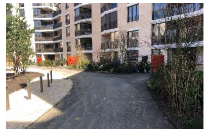
Überbauung Grammet der Bürgergemeinde Liestal
