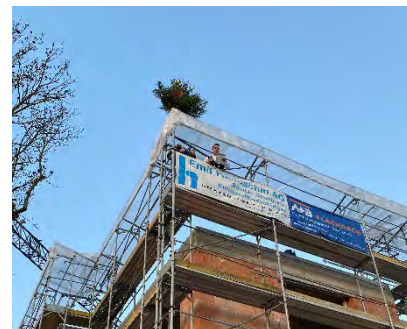
Richtfest in Reinach
