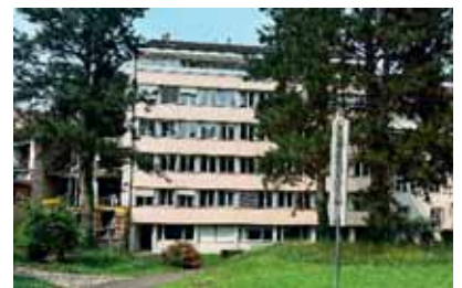
Umbau eines Bürohauses in der Schutzzone zu Wohnen für unsere PK Trikolon
